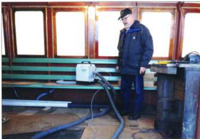
Christer Eliasson visar upp avfuktaren som Färjan 4 fått som gåva från Munters. Här är den inkopplad till pannan. Foto Gunnar Söderberg 19 november 2016
