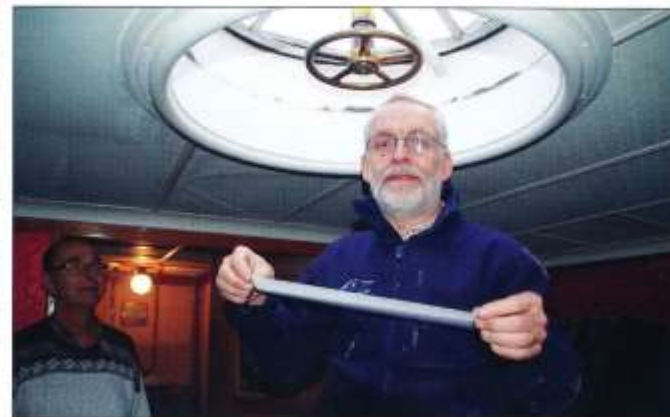
Torsten Asberg renoverar skylt i maskinen. Enligt specifikationen från 1914 är samtliga skylt gjorda av guld tackjärn men lika fullt svåra att hålla helt täta från regn och stänk från gyll vid mycket hårt väder. Foto Bo Starmark
